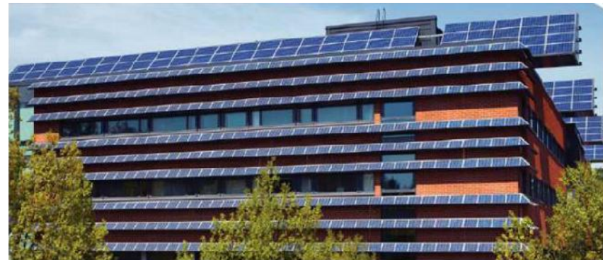
Kuva 40. Aurinkosähköpaneeli aurinkosuojalippana Vaisalán päärakennuksessa. (alkuperäinen kuva Naps Systems Oy 2013)
