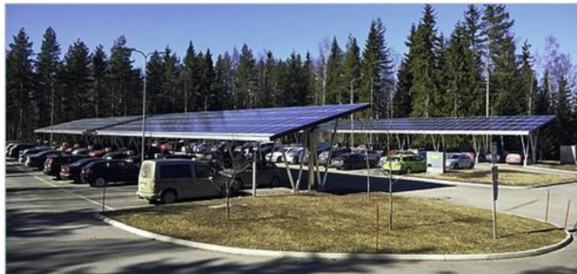
Kuva 35. Lappeenrannan teknillisen yliopiston pihalla on autokatosten katokset tehty aurinkopaneeleista. (Motiva Oy 2014, alkuperäinen kuva Jere Ahola)
